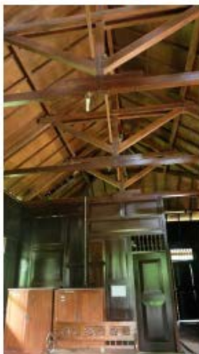
Konstruksi atap rumah terbuat dari kayu dan dinding rumah juga terbuat dari kayu
