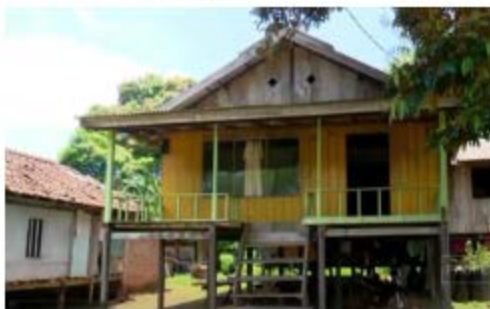
Gambar 4-53 Letak Kamar Mandi diluar Bangunan Rumah Panggung
