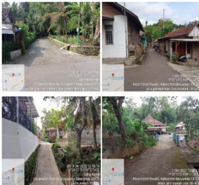
Gambar 4-85 Kondisi Infrastruktur Jalan Permukiman Tradisional Kalitanjung
