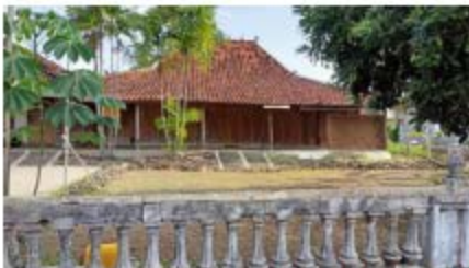
Atap genteng tanah liat berbentuk limasan
