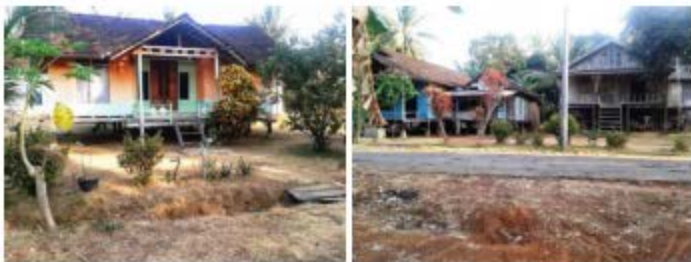
Gambar 4-52 Kondisi Infrastruktur Jalan dan Drainase Permukiman Tradisional Kampung Bugis
