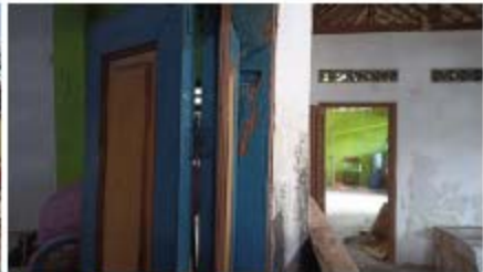
Dinding : Batu bata dengan ukuran besar dan dipasang 1 bata (melintang) dengan tebal tembok 25-30cm
