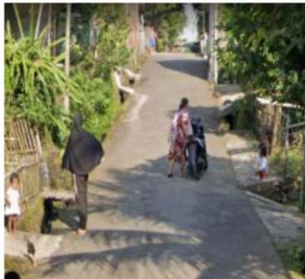
Gambar 4-86 Kondisi Saluran Drainase
