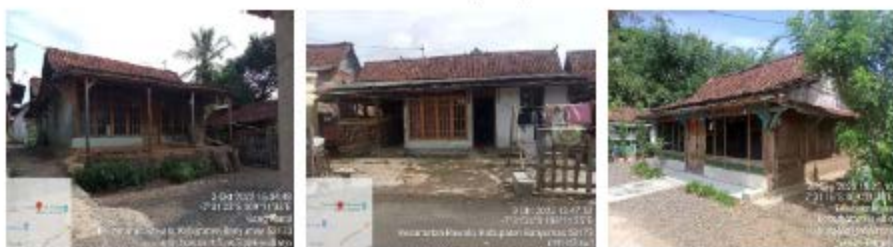
Gambar 4-84 Kondisi Bangunan Tradisional Kalitanjung
