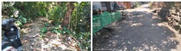
Gambar 4-17 Kondisi Infrastruktur Jalan di Kampung Jalawastu
