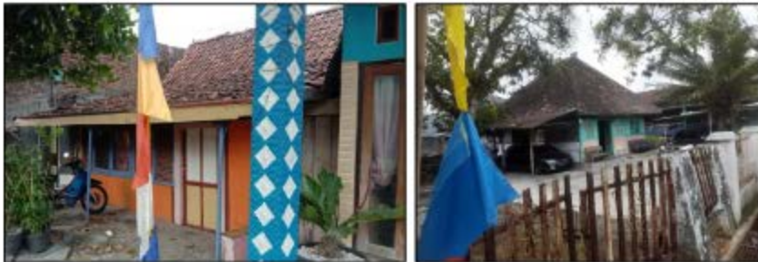
Gambar 4-57 Kondisi Bangunan Tradisional Kadilangu
