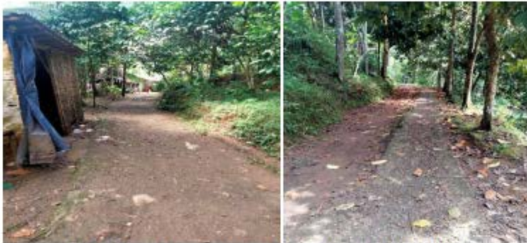
Lebar jalan 1,5 meter dengan material jalan berupa cor beton
