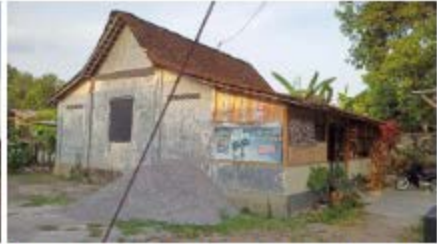
Atap Genteng berbentuk kampung, ada yang ditambahkan atap miring kesamping (sinom). Rangka atap kayu, bambu
