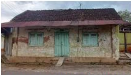
Dinding : Batu bata dengan ukuran besar dan dipasang 1 bata (melintang) dengan tebal tembok 25-30cm
