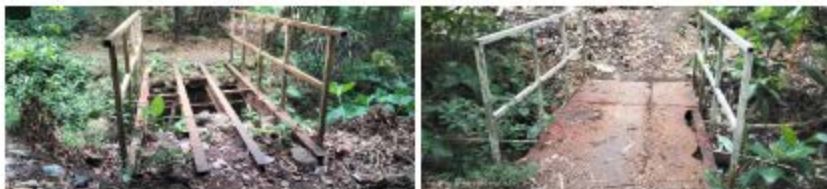
Gambar 4-18 Kondisi Infrastruktur Jembatan di Kampung Jalawastu
