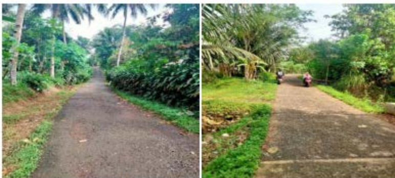
Lebar jalan 2,5 meter dengan material jalan berupa aspal
