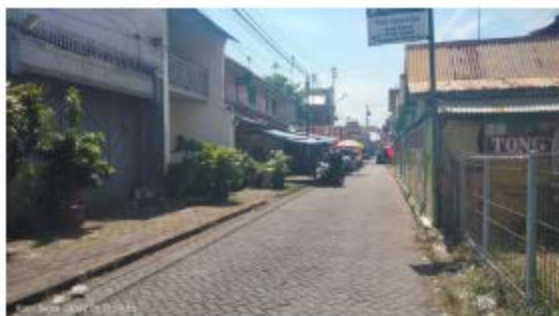
Gambar 4-69 Kondisi Saluran Drainase
