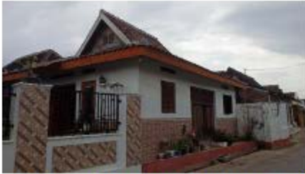
Atap Genteng berbentuk kampung, ada yang ditambahkan atap miring kesamping (sinom). Rangka atap kayu, bambu
