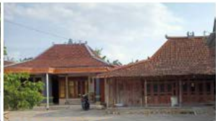
Atap genteng tanah liat berbentuk limasan
