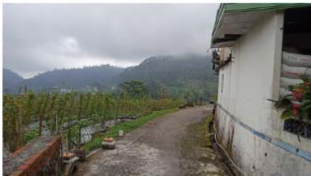
Gambar 4-46 Kondisi Saluran Drainase
