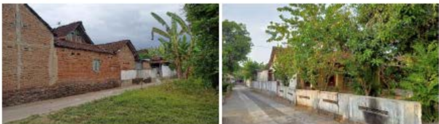
Jalan Lingkungan dengan lebar 2-3 m & Panjang total 3.358m. Sebagian besar berupa jalan cor beton dengan kondisi masih cukup baik
