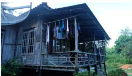
Teras rumah memiliki konstruksi material kayu
