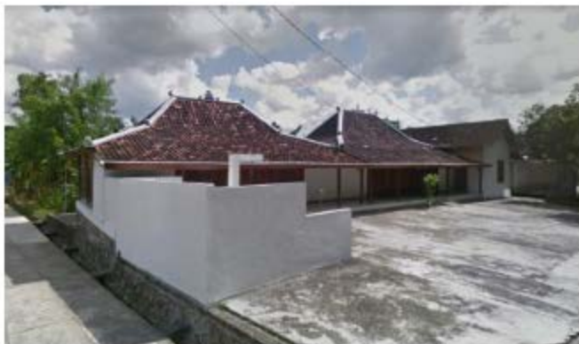
Gambar 4-31 Kondisi Saluran Drainase
